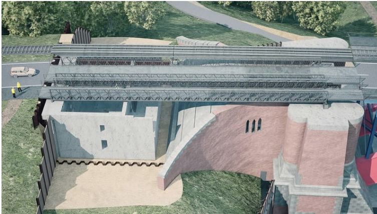
Bild 1: Visualisierung des neuen (links) und des alten (rechts) Widerlagers auf der nördlichen Kanalseite mit Behelfsbrücken (WNA NOK)
